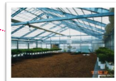
園芸鉄骨ハウス
